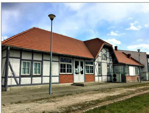
Fot. 13 Dworzec kolejowy (ob. CETiK)
