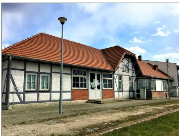
Fot. 13 Dworzec kolejowy (ob. CETiK)
